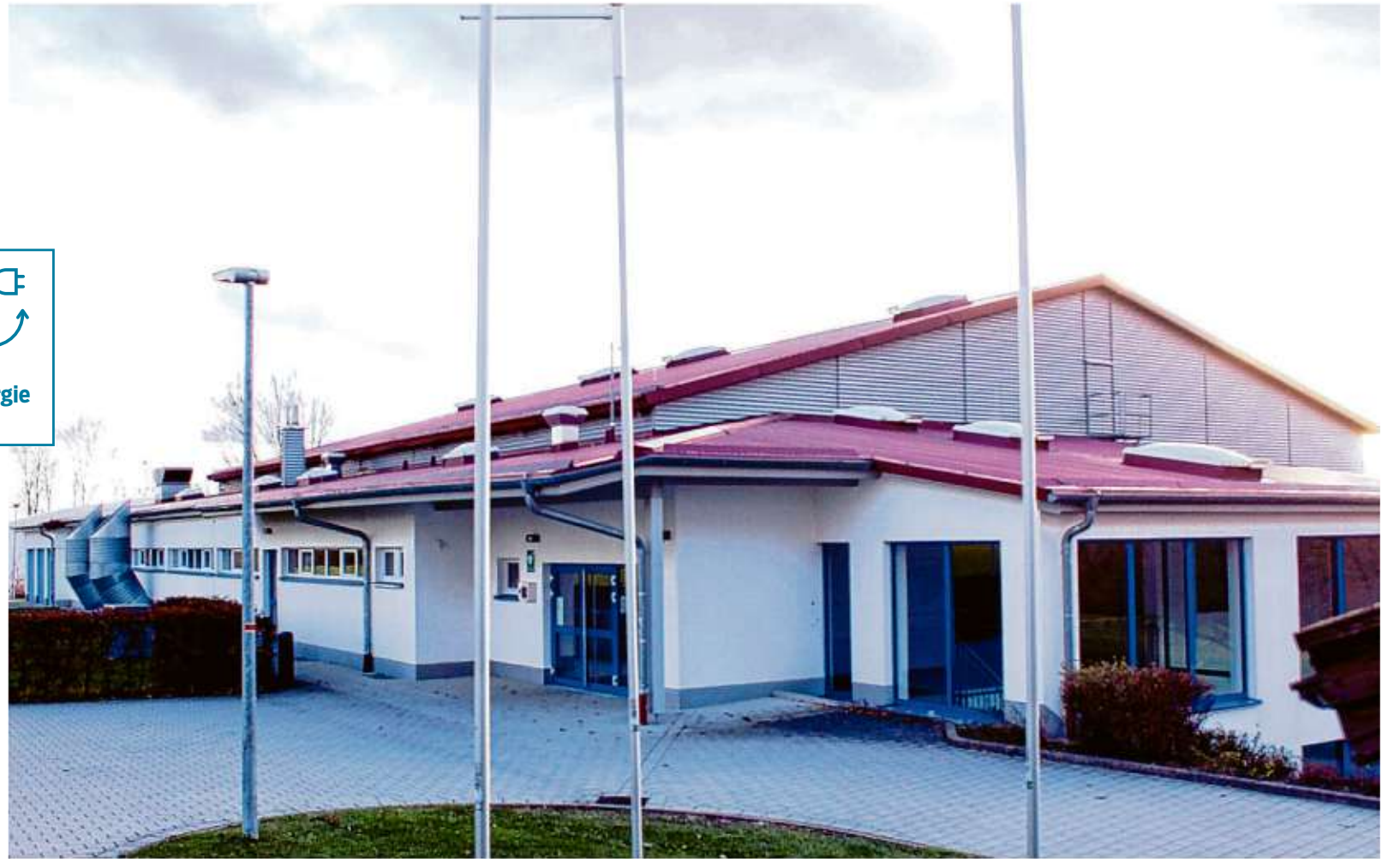
Auf dem Dach der Obersontheimer Schubarthalle soll eine 170-Kilowatt-Peak-PV-Anlage installiert werden. An dieser sollen sich Bürger beteiligen können. Foto: Sigrid Bauer
