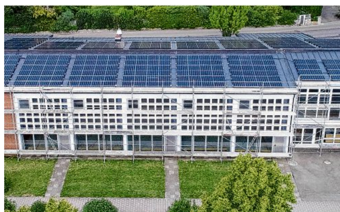
Die Solar-Panels auf dem Dach der Stadthalle Vellberg. Foto: BEVB
